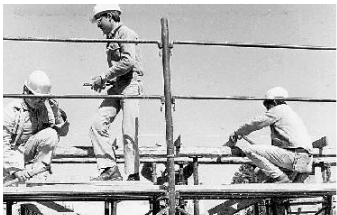
Operai edili all'opera su un'impalcatura
